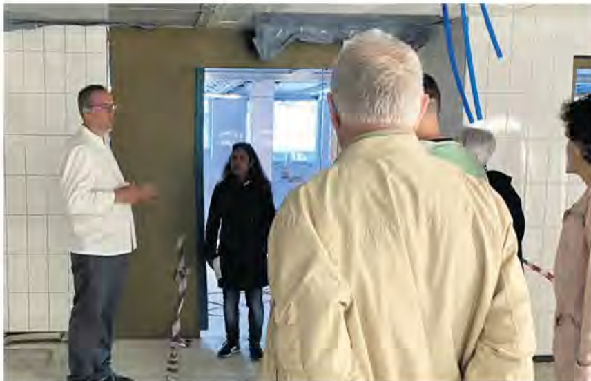
Rund 200 Personen nutzten die Gelegenheit und liessen sich durch Bremgartens grösste Baustelle führen.
