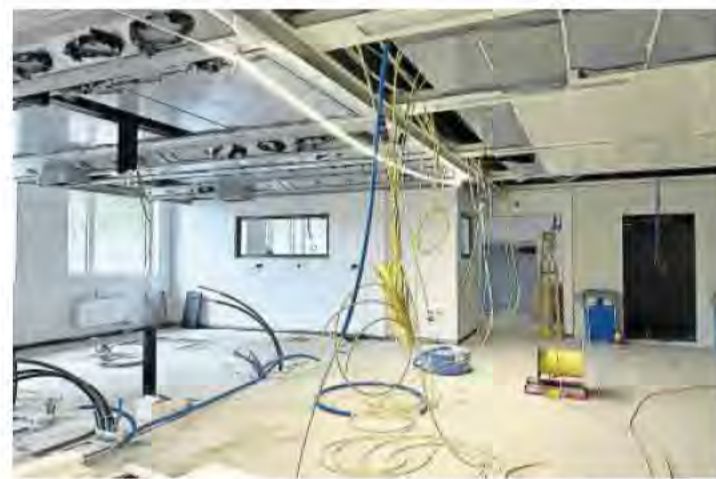
Die Innenausbauarbeiten am Haus Allegra sind schon weit vorgeschritten. Bild: Nathalie Wolgensinger
