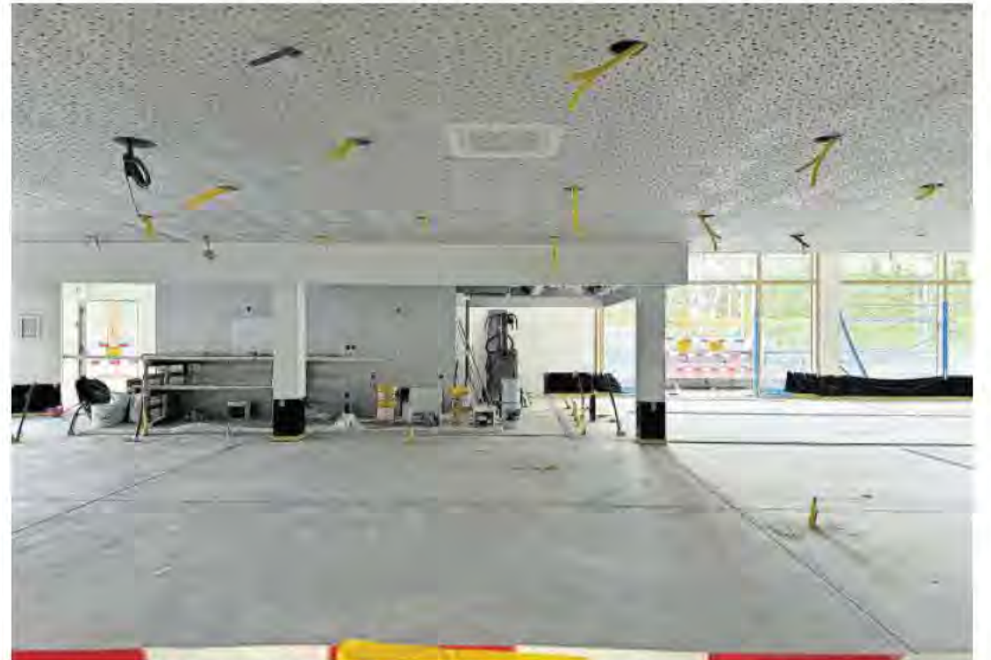
Wer schlecht zu Fuss ist und einen Lift braucht, konnte bisher die Baustelle nicht besichtigen. Eine Besichtigung wurde nun aber für alle ermöglicht. Bild: Nathalie Wolgensinger
